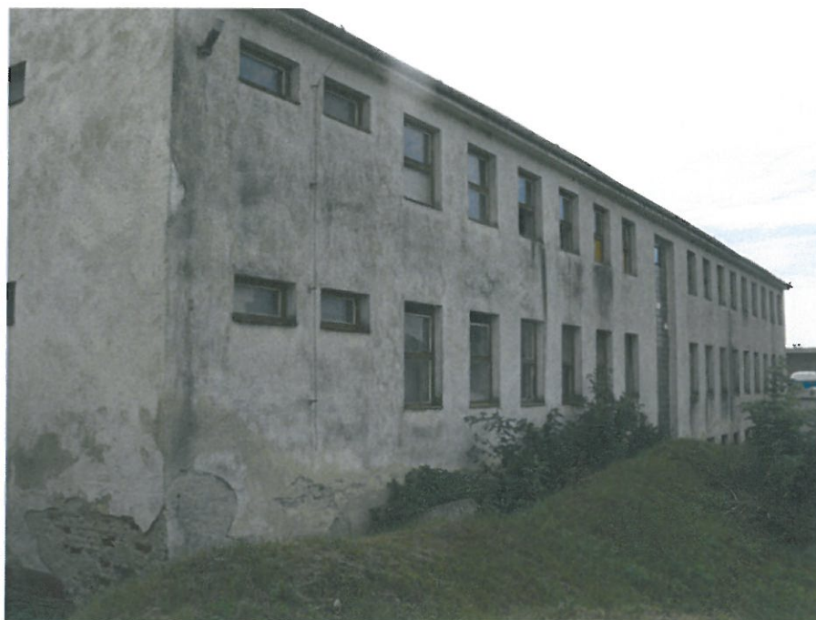
Obr. 2 – pohled na západní fasádu objektu
