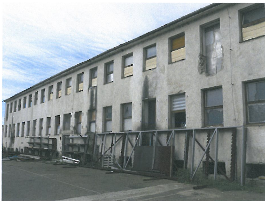
Obr. 1 – pohled na východní fasádu ubytovacího objektu
