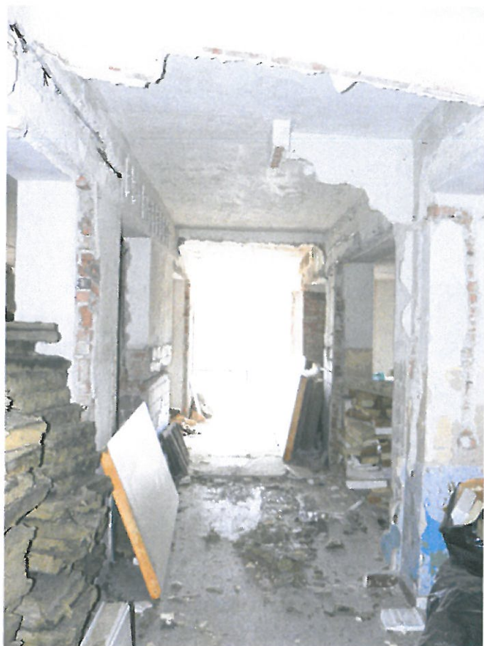
Obr. 11 – vybourané příčky mezi nosnými pilíři v nadzemním podlaží v prostoru chodbového traktu
